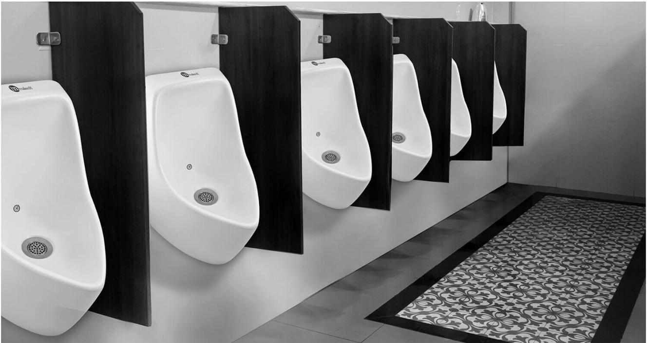
Los mingitorios ecológicos Makech se caracterizan por eliminar por completo el uso de agua, permitiendo de esta manera ahorrar entre 250,000 y 300,000 litros de agua al año por equipo instalado, además del ahorro obtenido por no utilizar refacciones, ni reparaciones a fluxómetros.
